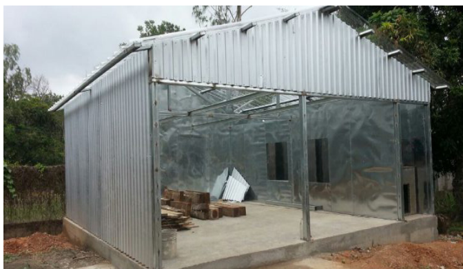
Figura 3: Imagen de un prototipo de Sistema Solar para el Secado de Madera
